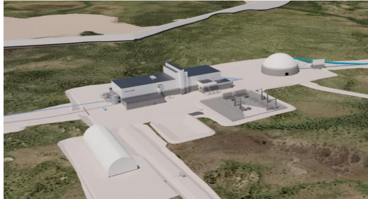
Secteur du concentrateur – Vue vers le sud
